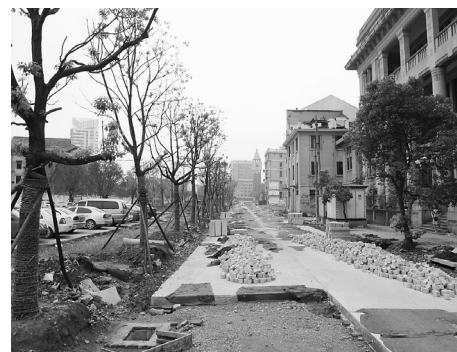
改造中の青島路の様子
